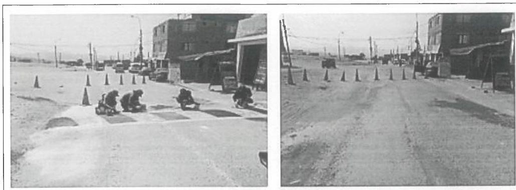
AV. 225 CALLE LOS TÉCNICOS AA.HH. HIROSHIMA (CONSTRUCCIÓN DE ROMPE MUELLE)
