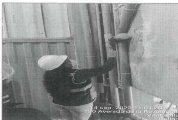
Inspecciones técnicas de seguridad en edificaciones (locales comerciales)
